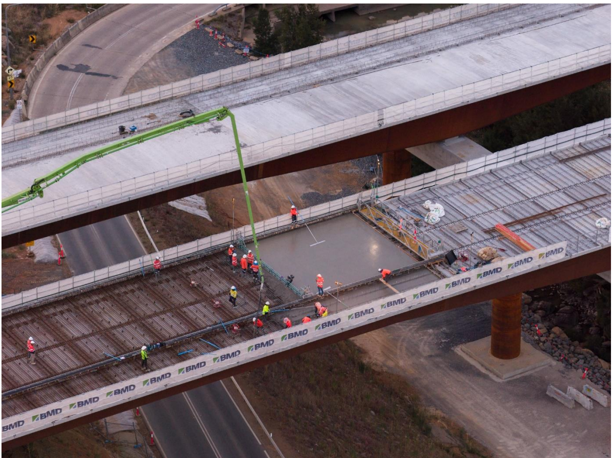
Molonglo River Bridge – Concrete pour
